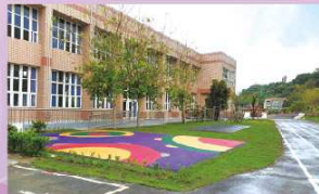
111.5 活動中心戶外場地完工
