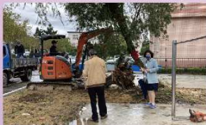
111.2戶外場地移樹工程
