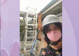
111.5.電梯鋼構組裝、吊裝
