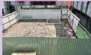
111.4.無障礙電梯工程施工中
