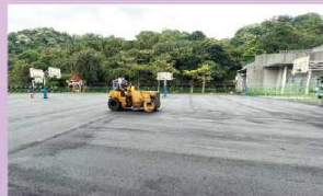
111.4.籃球場整建工程施工
