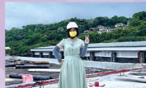
111.4.科技館屋頂防水隔熱工程
