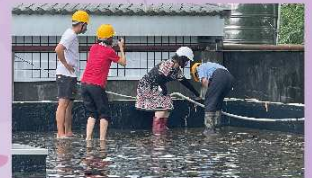
111.5.科技館屋頂試水查驗
