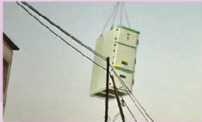
111.3 吊運裝設高壓配電盤
