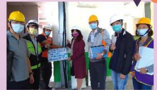
監造校長工程驗收電力改工程
