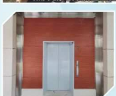
無障礙電梯完工外觀
