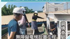
無障礙電梯設置工程
