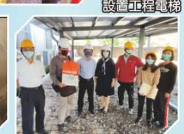
111.10腳踏車棚整建灌漿工程
