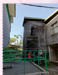
114.03能資源外牆整修
