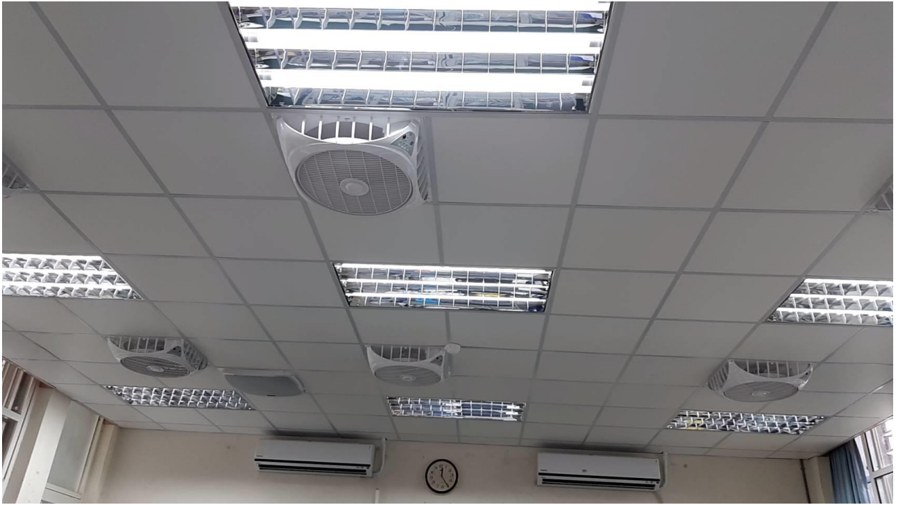
改善班級照明及天花板、風扇安裝
