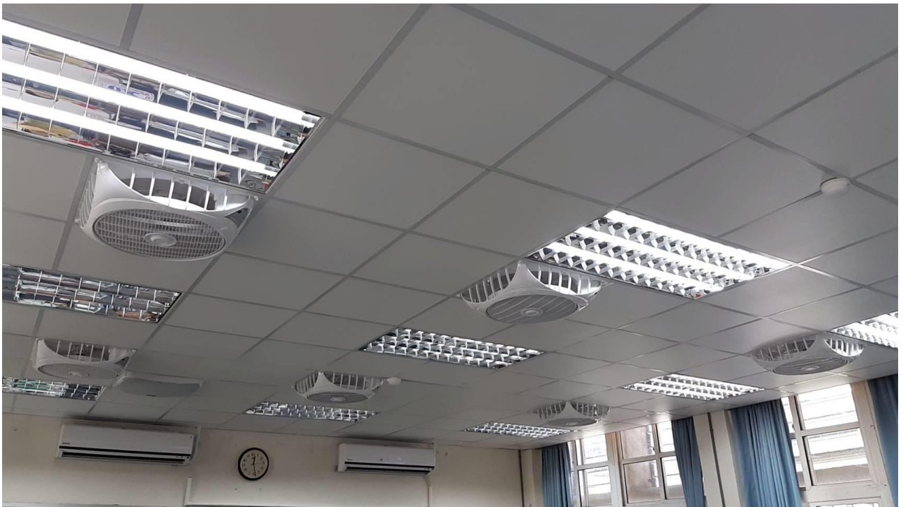
改善班級照明及天花板、風扇安裝
